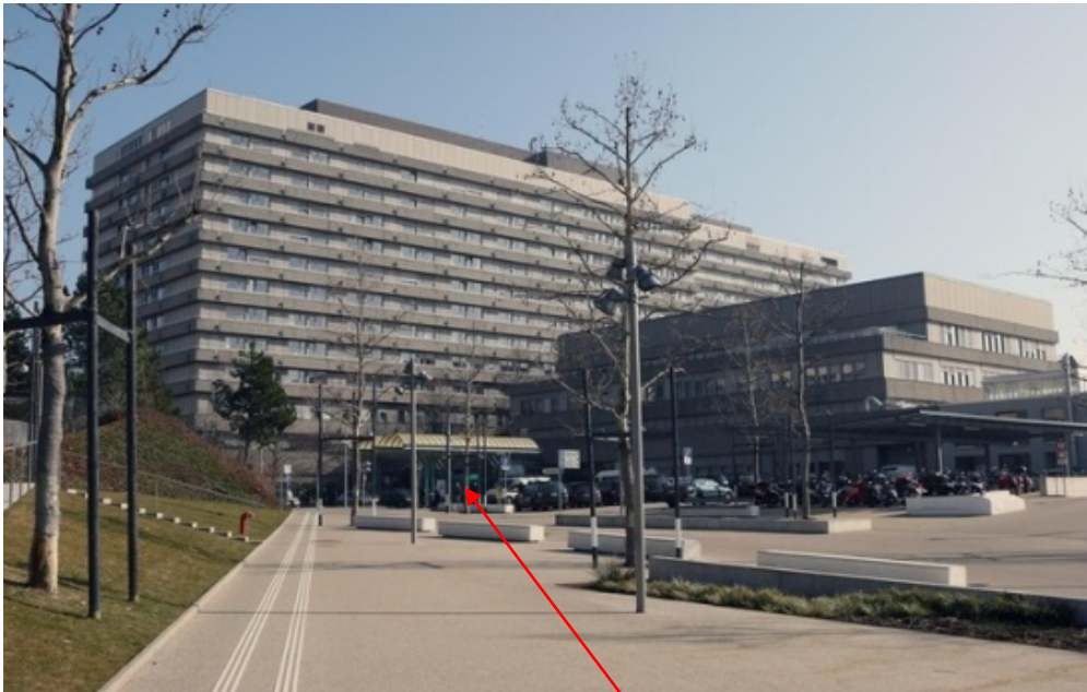
(Bâtiment hospitalier du CHUV par entrée principale)
