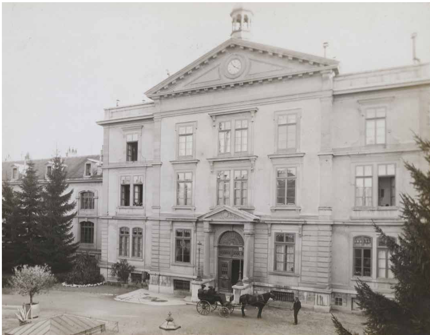
Façade et cour nord de l'Hôpital cantonal, vers 1900-1915. Collection de l'Institut des humanités en médecine.
