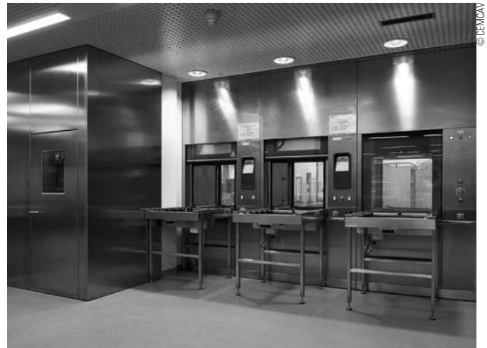
Tous les équipements de lavage et de stérilisation sont installés à double: à gauche, pour les chariots, à droite, pour les instruments chirurgicaux et toutes sortes de dispositifs médicaux.
