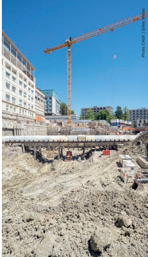
La station de métro a disparu sous neuf poutres de 50 tonnes chacune (à gauche). Le tunnel de liaison entre la maternité et le bâtiment principal a été transformé en pont suspendu (à droite).
