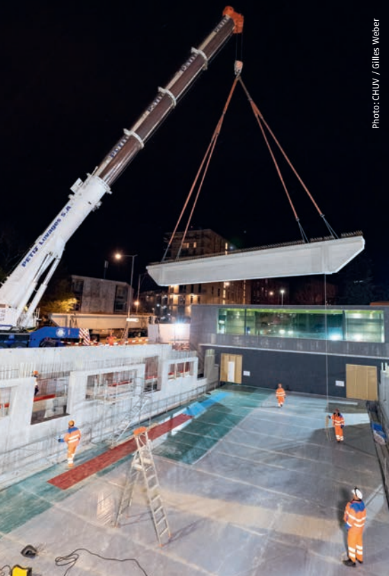
La station de métro a disparu sous neuf poutres de 50 tonnes chacune (à gauche). Le tunnel de liaison entre la maternité et le bâtiment principal a été transformé en pont suspendu (à droite).
