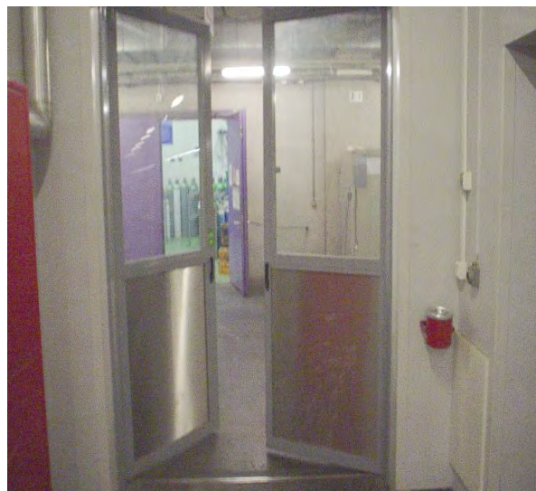
↑ ↑ Porte en situation d'alarme feu reste fermée, peut être poussée Système anti-panique
