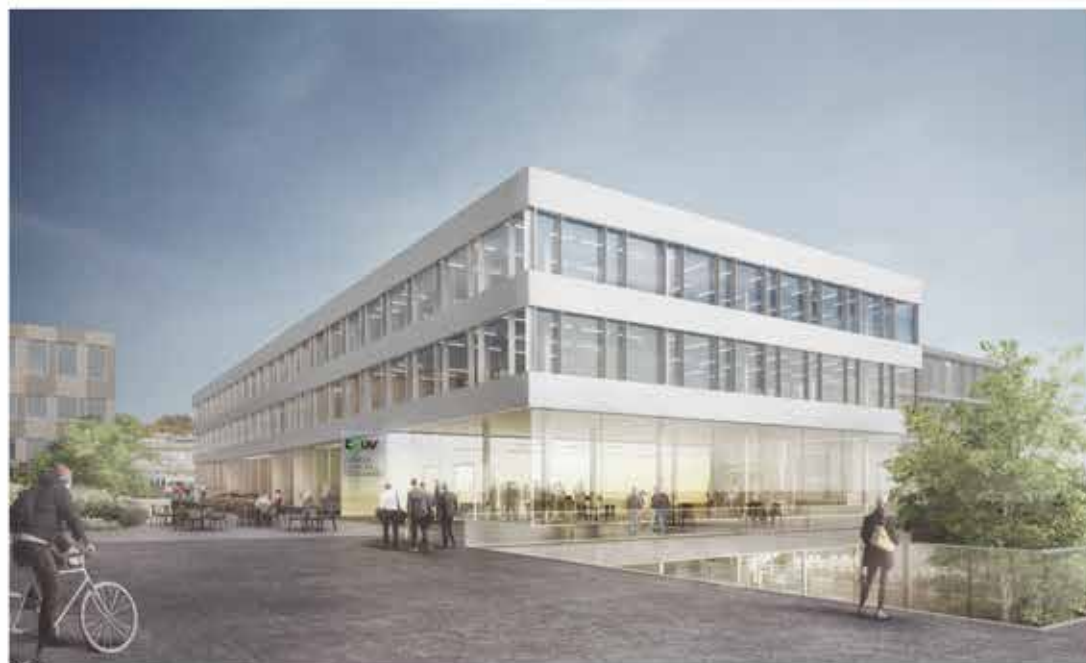
vue de l'extérieur
