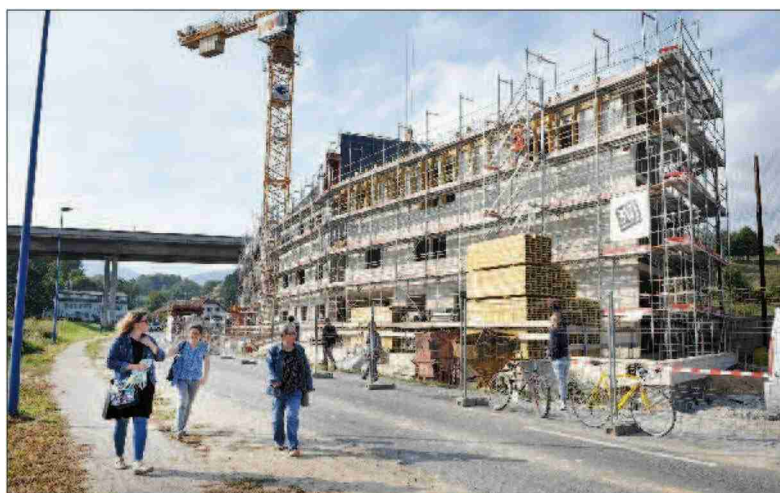
Actuellement en construction, le bâtiment ouvrira ses portes été 2017. Michel Duperrex
