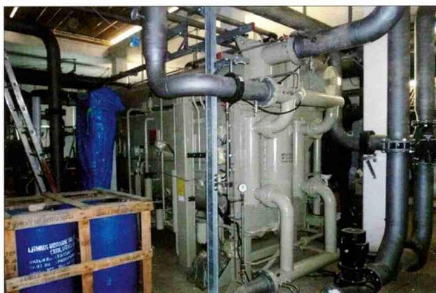
La mise en service fournira une puissance de 2 MW avec une machines à absorption thermique qui fournit deux tiers du froid nécessaire et deux machines à compression qui assurent, à partir de l'électricité, les pointes représentant 15% des besoins.
