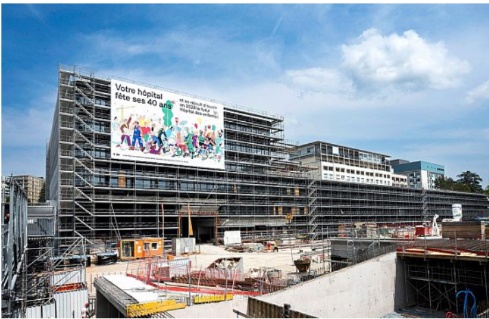
L'Hôpital des enfants est le plus gros chantier en cours sur le site du Bugnon. Il ouvrira en 2024. CHUV/GILLES WEBER
