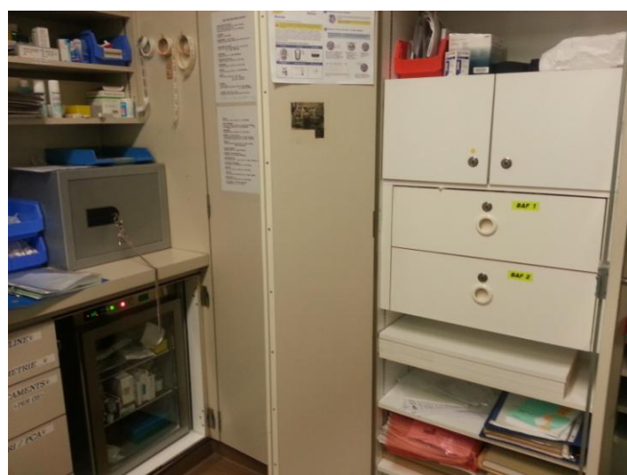
Figure 11 : Coffre et armoire à stupéfiants de la salle de réveil du BOP05
